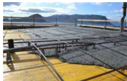
Mix van Dramix® en post-tensioning vervangt traditionele passieve versterking in on grade toepassingen
